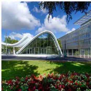
CRÉDIT AGRICOLE - CHANTIER ÉOLE Montrouge, France
